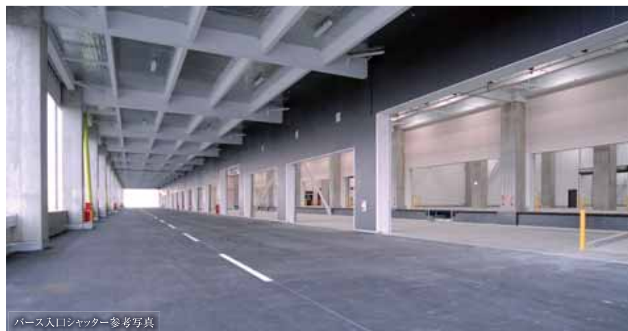
パース入口シャッター参考写真
