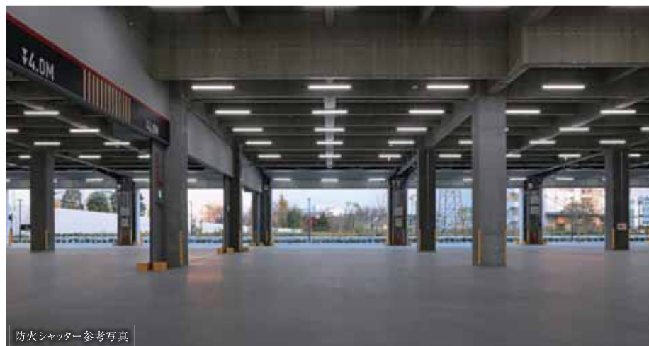
防火シャッター参考写真
