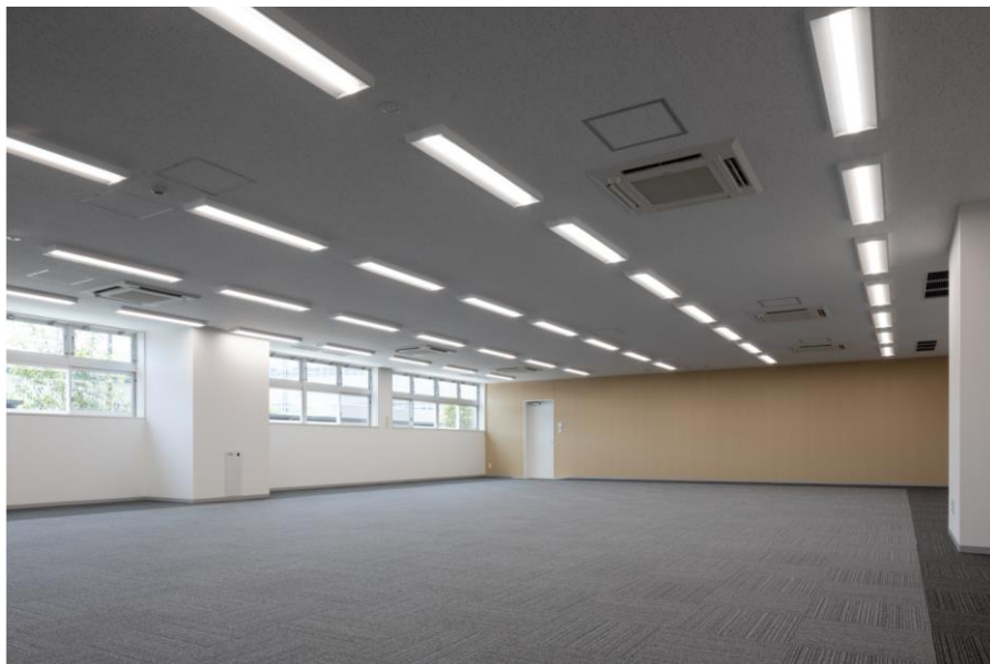
【中央区画_1階事務スペース】
