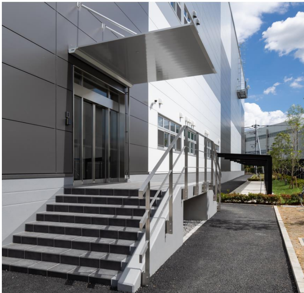
【西区画_エントランス】
